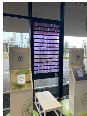
研究所内に設置した調光ガラス
