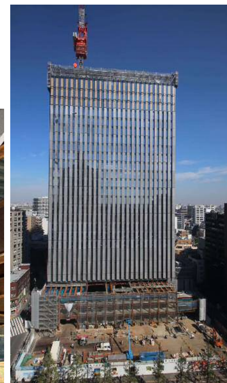
南側全景(令和4年10月下旬)
