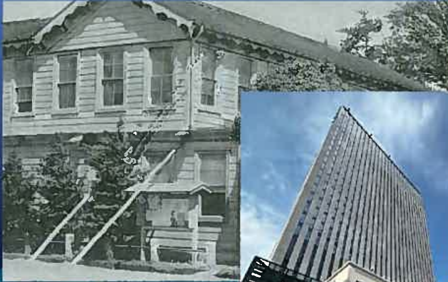
川崎市制が始まったころの川崎市役所。 庁舎は震災被害を受けた川崎市の建物につかえ傷で 応急処置したものだった。
