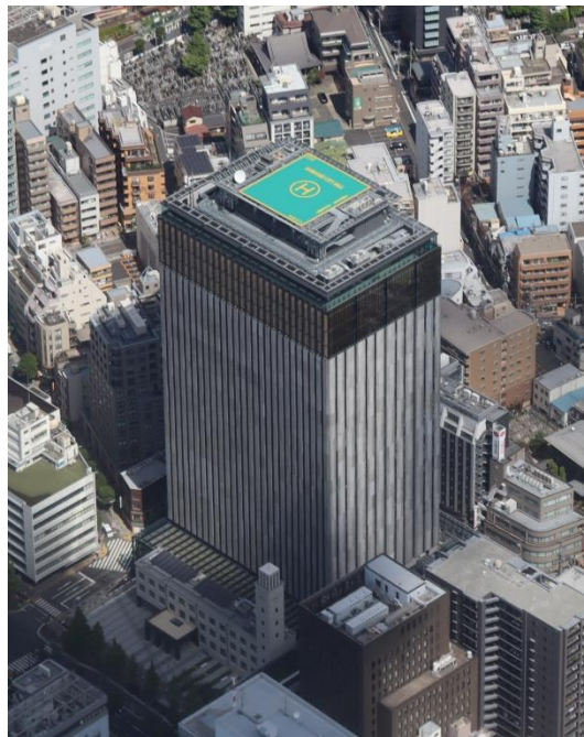
【川崎市役所本庁舎】
