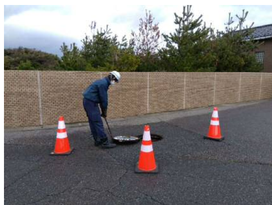
（志賀町での下水管きよの調査※の様子）
