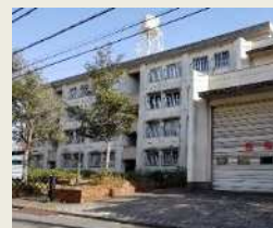
〈消防小田公舎〉
