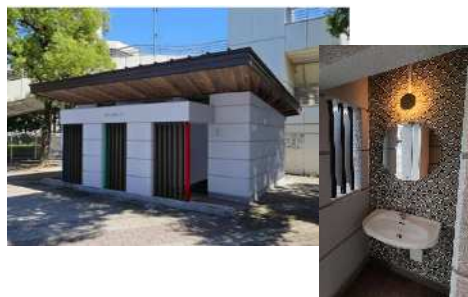
トイレリニューアル後
