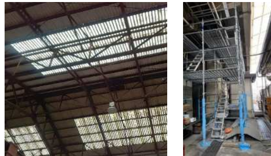
図表32 青果卸売場棟天井(左)と令和5年度改修工事(右)
