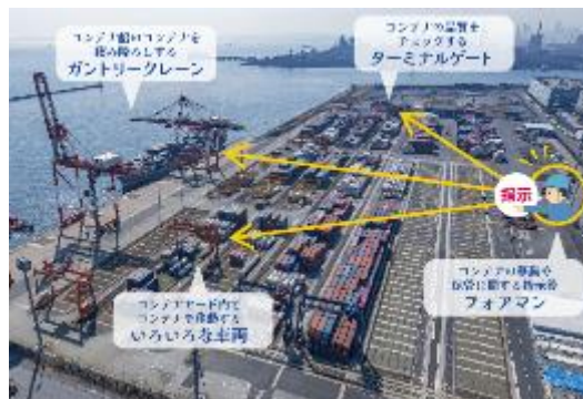
川崎港コンテナターミナル全景
