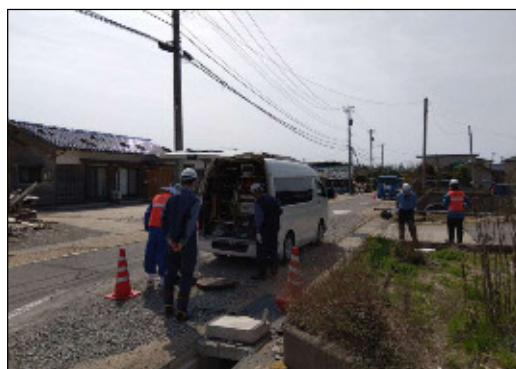
（輪島市での2次調査の様子 3/31撮影）
