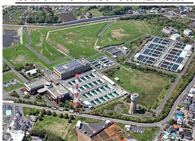
綾瀬浄水場の概要（増強整備前）
