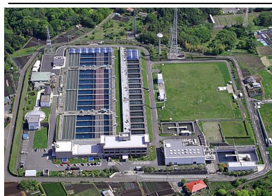
伊勢原浄水場の概要（増強整備前）
