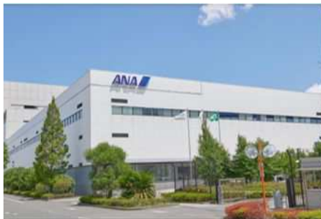
【ANAC 川崎工場】
