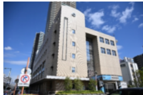
中原区役所【中原区】 1 階を木質化リノベーション
