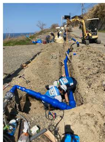
水道の仮設配管のための掘削状況（輪島市）
