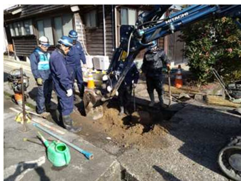
漏水している水道管の修理のための掘削状況（志賀町）
