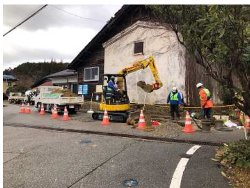
漏水している水道管の修理のための掘削状況（志賀町）
