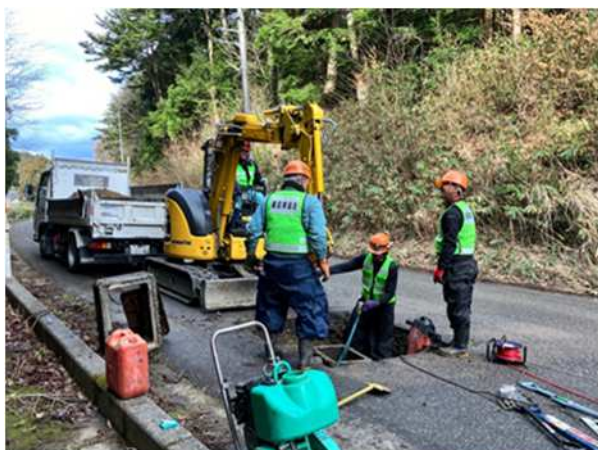
地下式消火栓付近の陥没の整備状況（志賀町）
