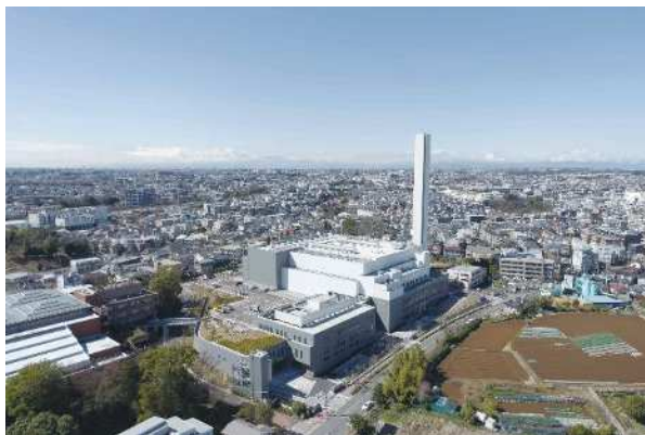
<川崎市 橘処理センター>
