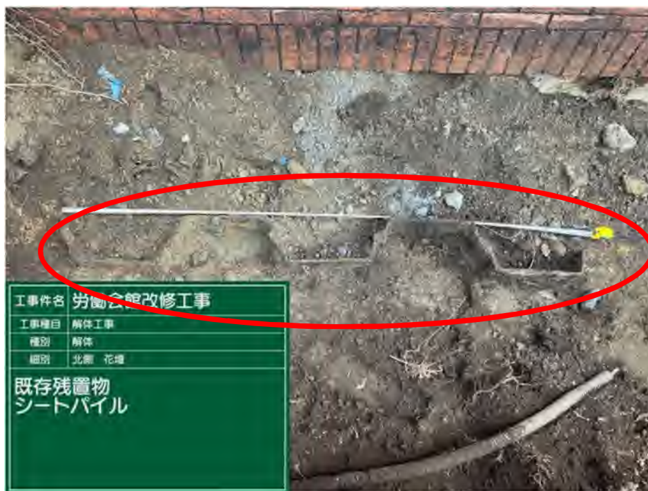
【埋設シートパイル】
