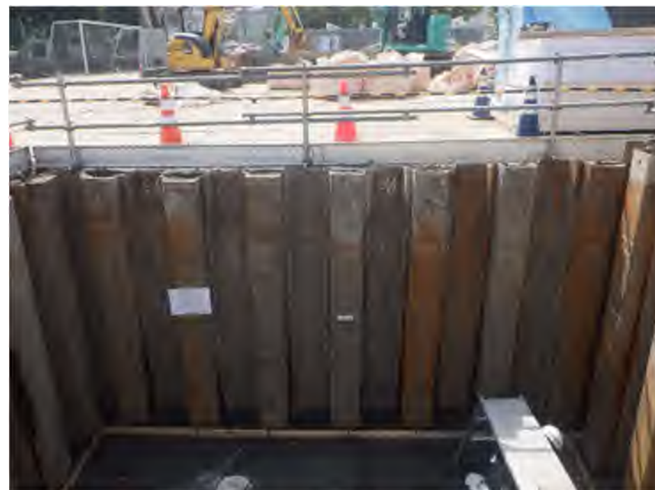
【他工事での事例】
