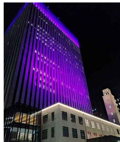
↑市役所本庁舎パープル・ライトアップの様子 (令和5年度)
