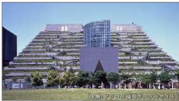
○1995年の様子（竣工当時）
