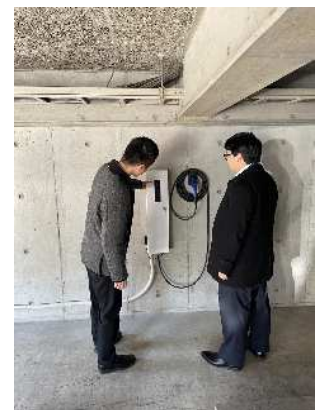
実証内容に関してミーティング enefla(株)×(株)南荘石井事務所×専門家
