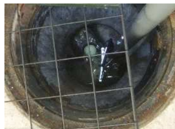
【検査具が污水管にたどり着いた様子】
