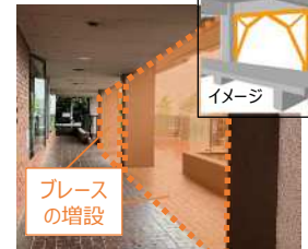
（宿泊棟の耐震補強） ※バリアフリー動線に制限
