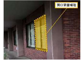
（大ホール棟の耐震補強）
