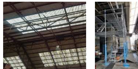
青果卸売場棟天井(左)と改修工事(右)
