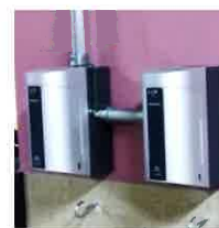
充電用コンセント
