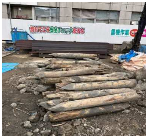
【撤去した地中障害物】
