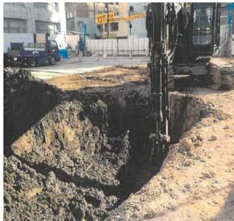
【掘削作業の様子】
