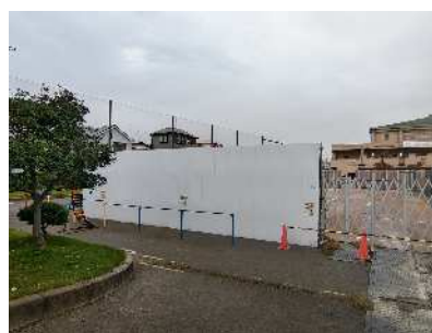
工事用仮囲い （校舎外壁塗装工事）
