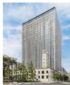
川崎市役所本庁舎
