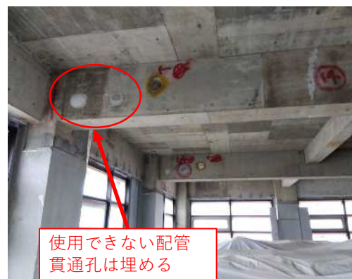
【設計図と異なる配管貫通孔の数】
