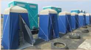
東日本大震災で使用されたマンホールトイレ（宮城県東松島市） （写真上、写真下 出典：国土交通省「マンホールトイレ整備・運用のためのガイドライン（2025年版）」から抜粋）
