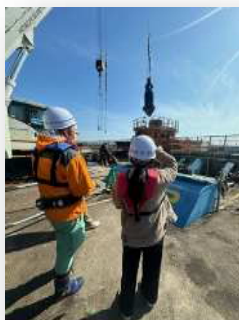
埋立地での掘削作業 見学の様子 (川崎港管理センター)
