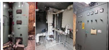
ボイラー 消火設備 受変電設備 （耐用年数を越えた設備）
