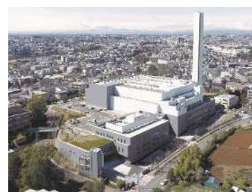
川崎市橋処理センター
