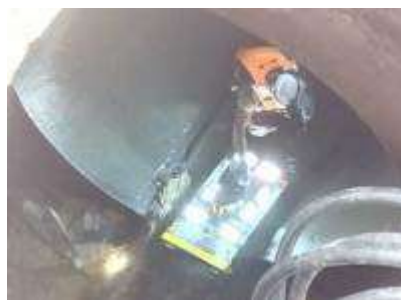
浮流式カメラ調査
