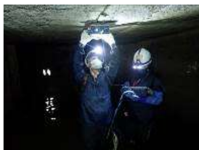
空洞調査 (管路内から実施)
