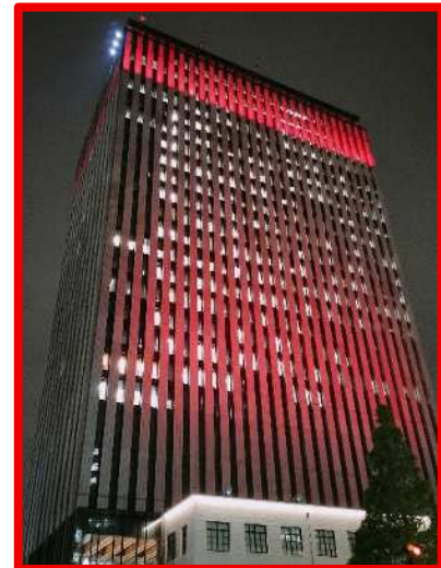
赤十字カラーに市役所本庁舎をライトアップ
