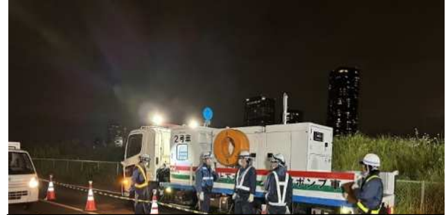
【排水ポンプ車規制帯内配置訓練】 （多摩沿線道路）
