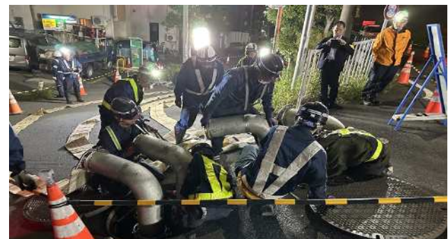
【L型管接続訓練】 （諏訪交差点内陸側）
