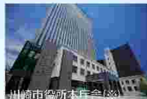
川崎市役所本庁舎※
