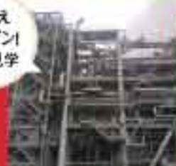
JERA川崎火力発電所
