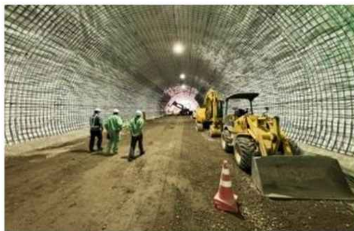
【工事中のトンネルの状況】
