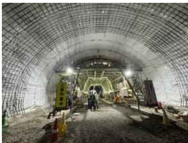
【直近の現場状況 セントル組立状況】
