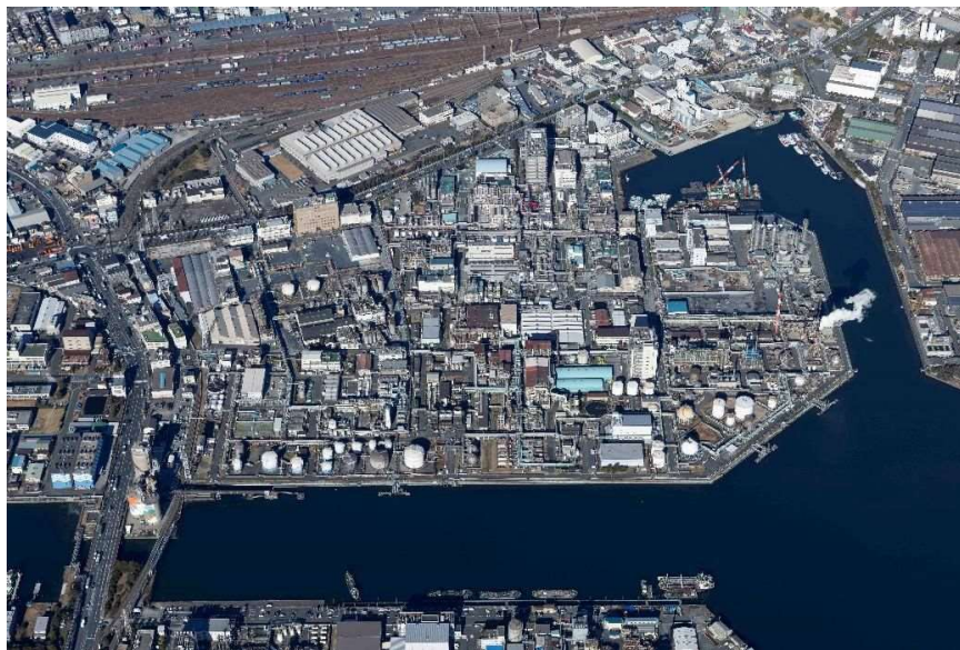
川崎製造所 航空写真
