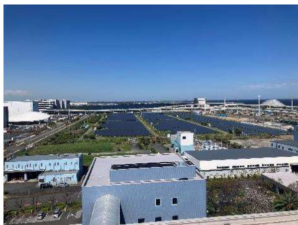
【写真1】別紙図2エリア②の俯瞰写真
