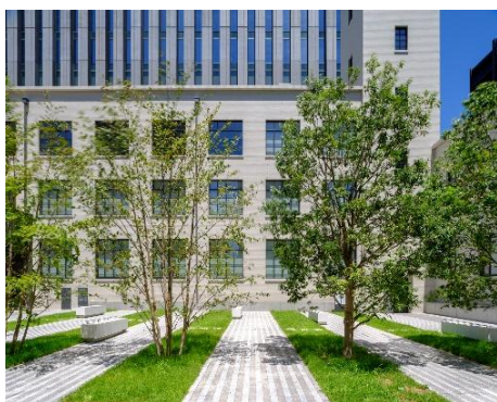
復元棟の1階に配置されたカフェと連動して使うことができる復元棟前広場のテラス。高木や芝生により、うるおいを感じながらベンチで過ごすことが可能となっている。
