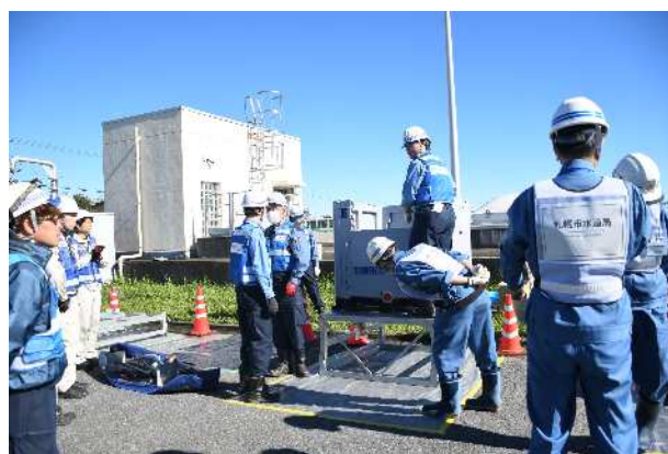
組立式給水タンクの組立
