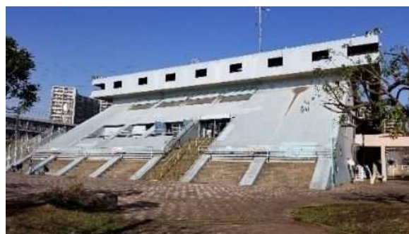
図 3-5 南部防災センター
