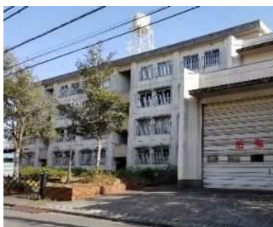
図 3-4 消防小田公舎
