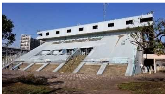
図 3-5 南部防災センター
