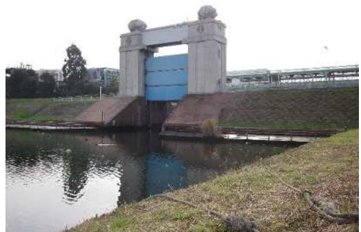
川崎河港水門
