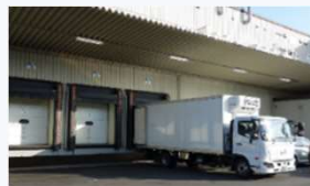
事業者が整備した低温管理設備
