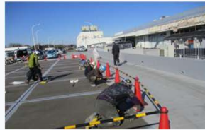
大規模屋上防水工事の様子
