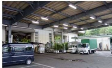
広範囲をカバーする屋根付き買荷保管積込所
