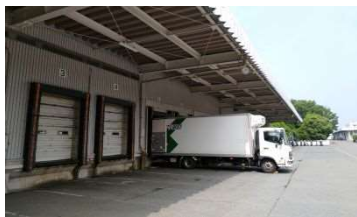
コンテナ全体を覆う大型庇
