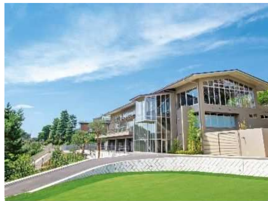
川崎国際生田緑地ゴルフ場クラブハウス
