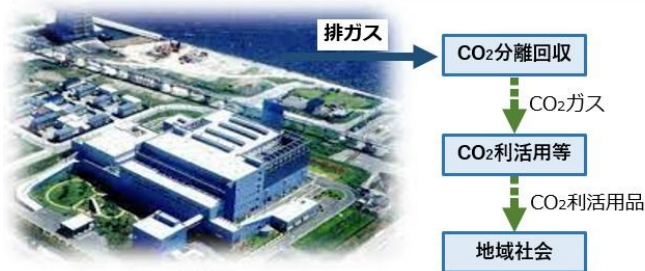
※ 現在の浮島処理センター
