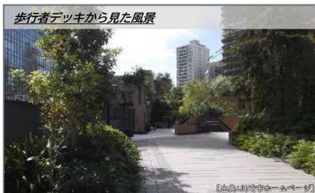
川崎駅から続く歩行者デッキと2階レベルで接続し、安全でスムーズな回遊動線を確保
