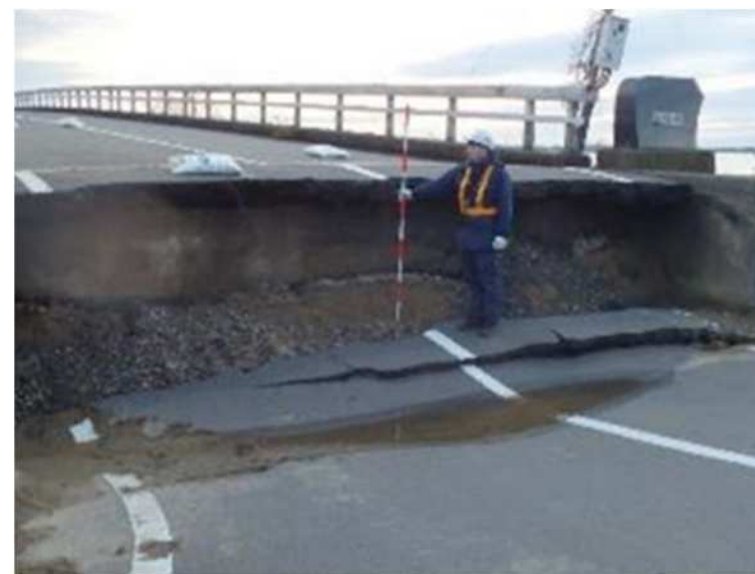
図 能登半島地震での橋りょうの被災状況 (出典)国土交通省資料
